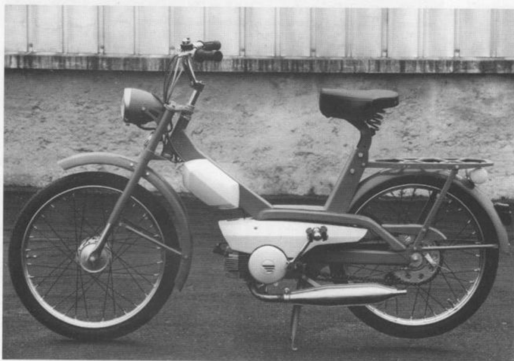
Un'interessante foto inedita di un esemplare di preserie del Lambrettino 39. Notare la forcella anteriore telescopica e il faro rotondo di generose dimensioni.
